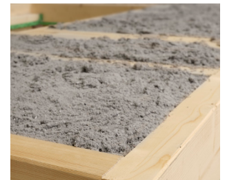
Verschiedenste Dämm-Materialien , wie bspw. Holzfaser, Mineralwolle und Zellulose können eingebracht werden.
