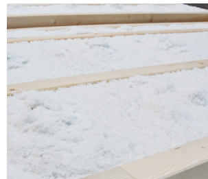
Verschiedenste Dämm-Materialien , wie bspw. Holzfaser, Mineralwolle und Zellulose können eingebracht werden.
