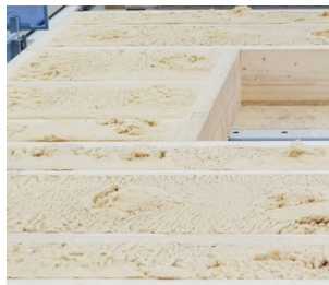
Verschiedenste Dämm-Materialien , wie bspw. Holzfaser, Mineralwolle und Zellulose können eingebracht werden.
